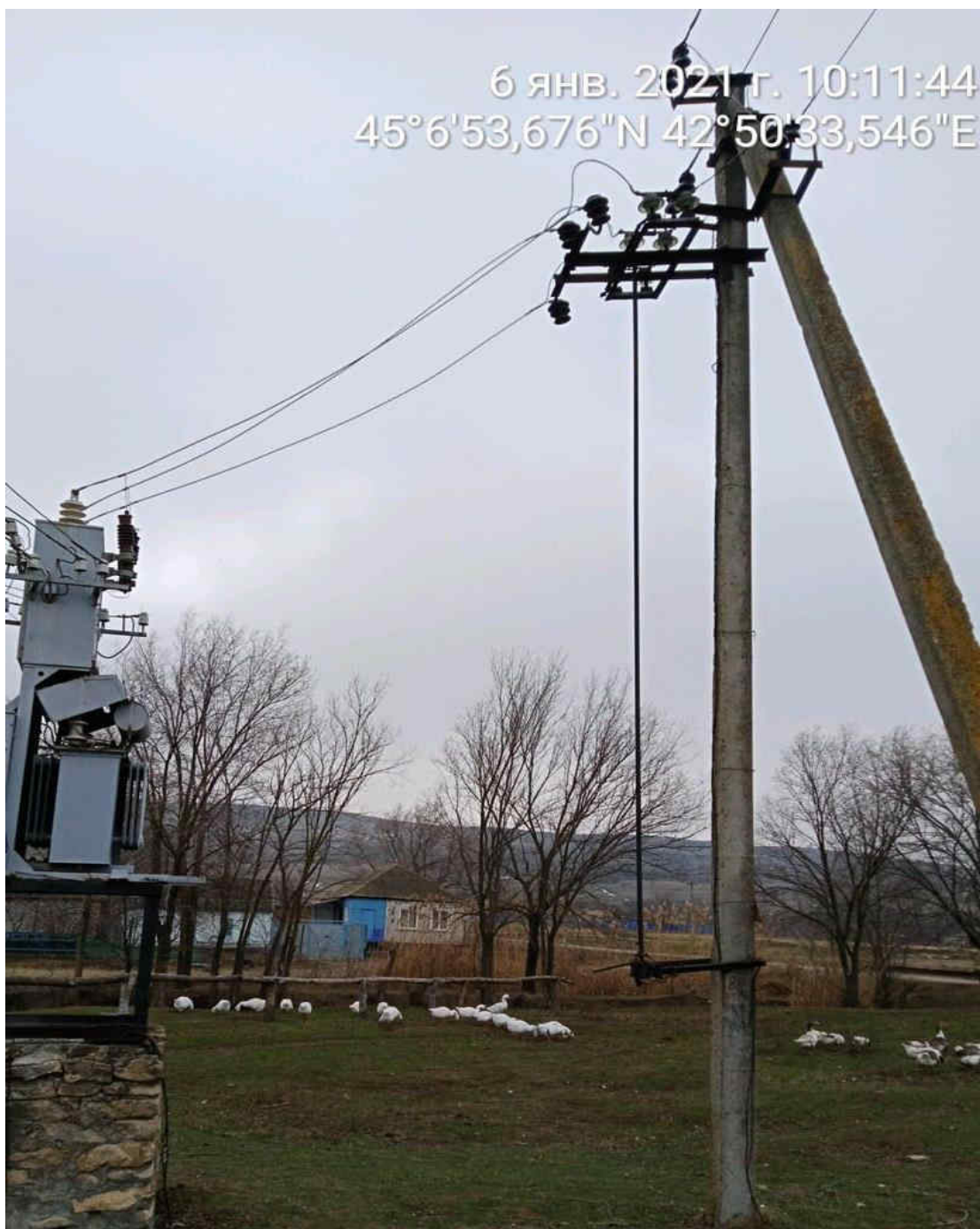
Общий вид разъединителя Р-14-1.
