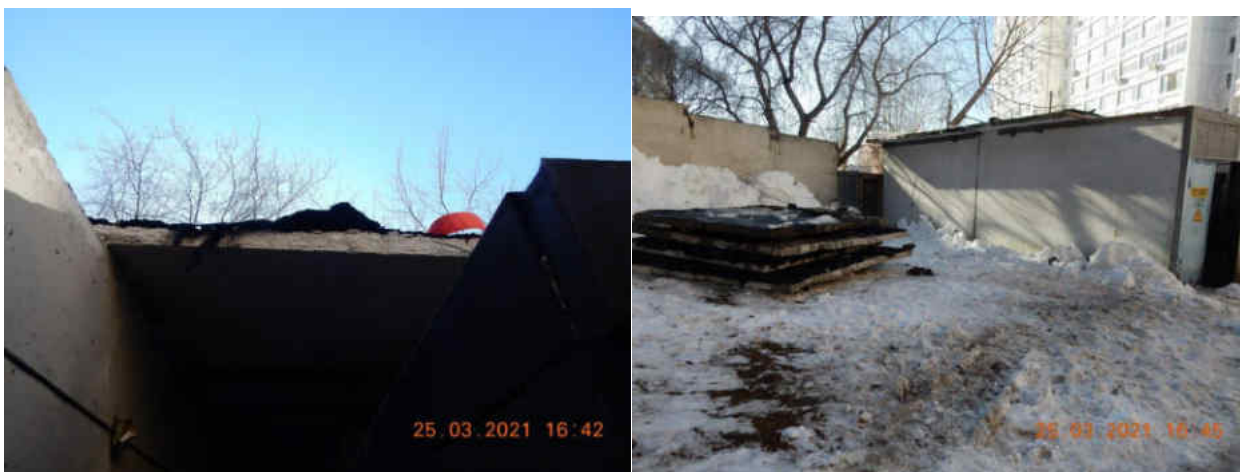
Демонтированная часть плит перекрытия над РУ-6 кВ ТП 5247
