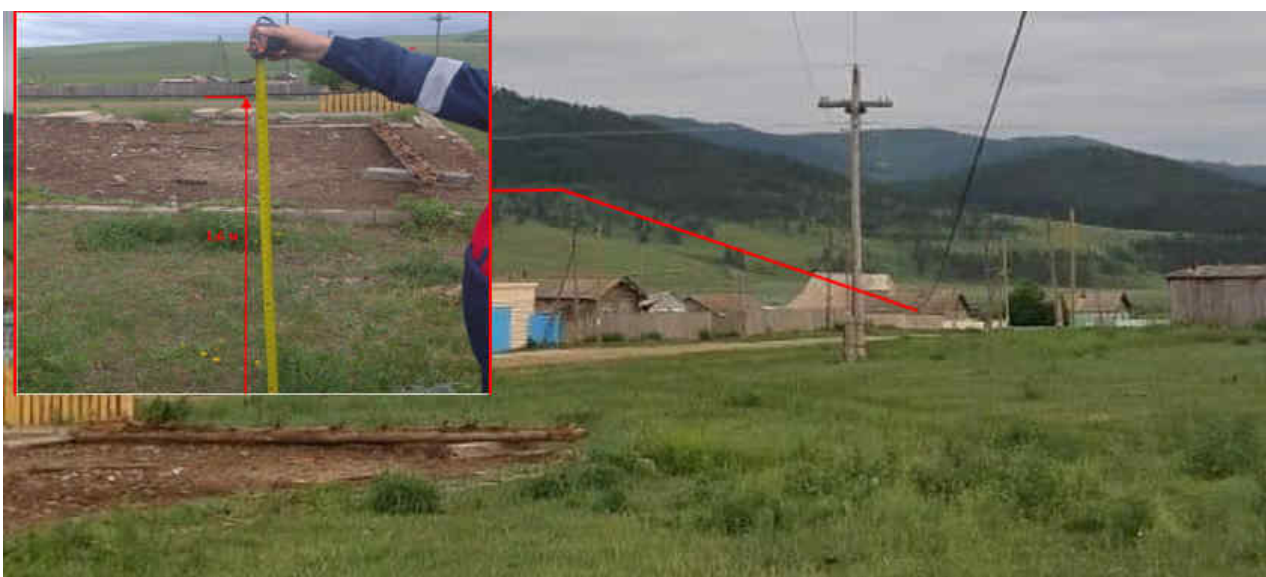
Место несчастного случая, провисший над землей провод ЛЭП в пролете опор №№75-75/1
