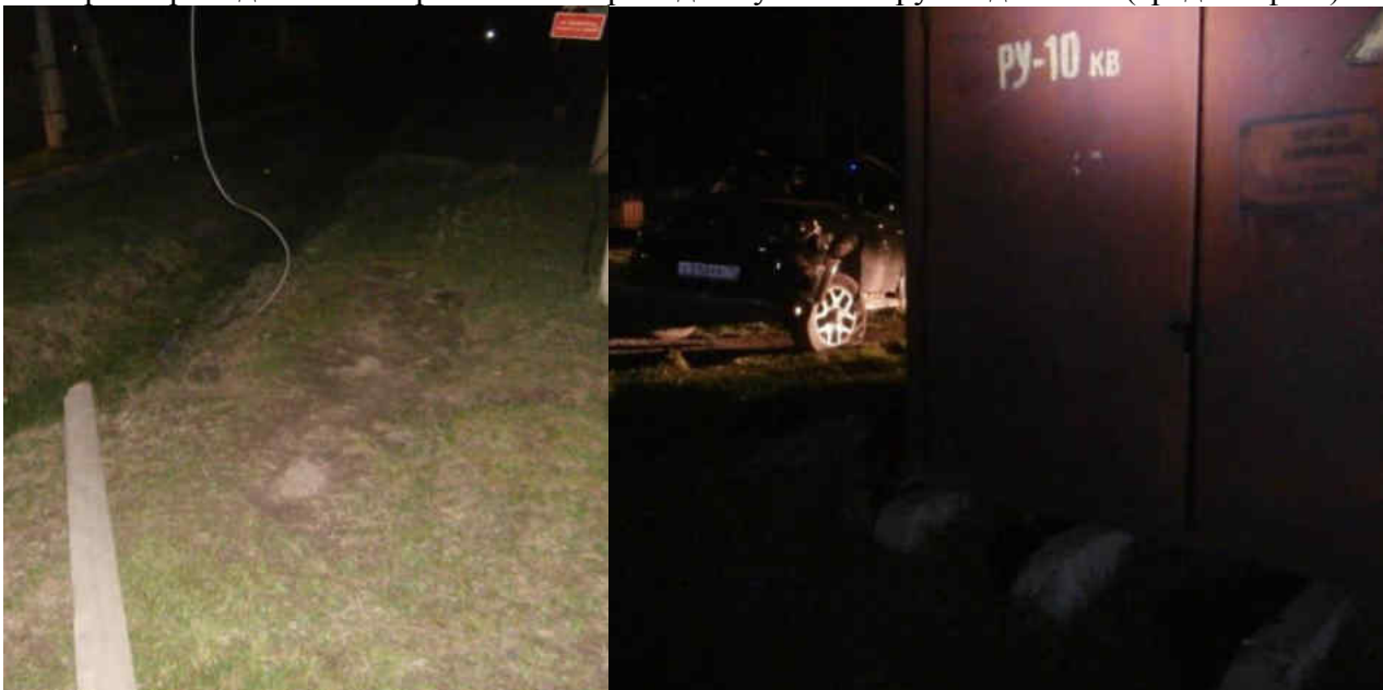
Оборванный спуск со стороны опоры и поврежденный автомобиль пострадавшего.
