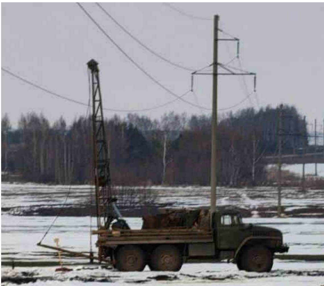
Местонахождение бурильной установки под ВЛ 110 кВ в пролете опор №№71-72
