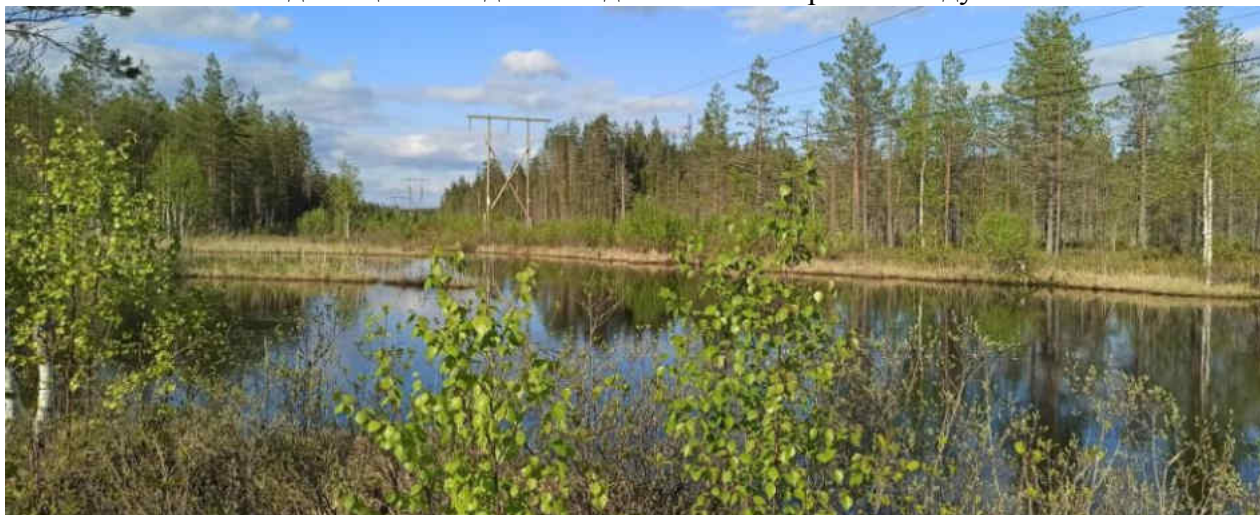
ВЛ 110 кВ Лоймола-Суоярви (Л-132), пролет опор №№18-19.
