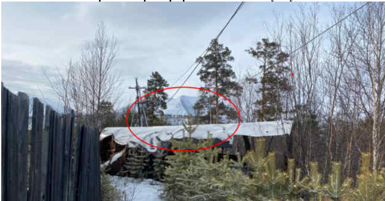
Место происшествия, пролет опор № 7/5-7/6 ВЛ-10 кВ ф. 5810 от ПС 220 кВ «Акусикан» (металлическая емкость)
