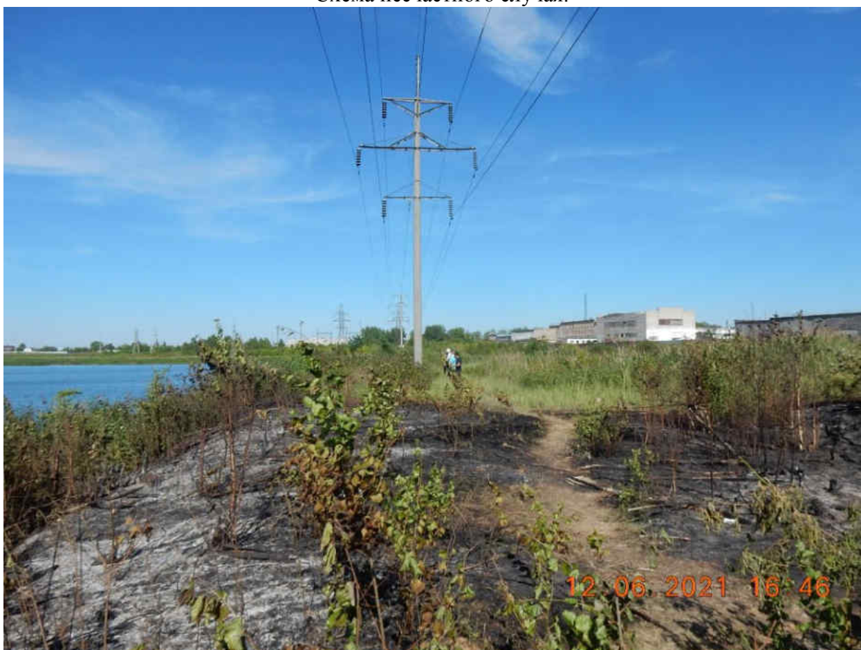
Вид на опору №30 отпайки ЛЭП со стороны места происшествия.
